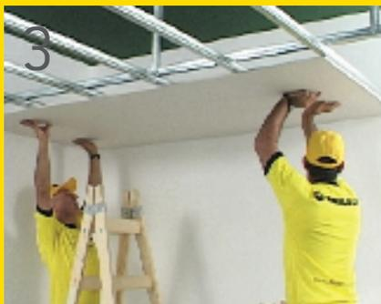
Para fijar las placas a los perfiles montantes, utilice tornillos T2 colocándolos cada 30cm y 15cm en los bordes de placas (juntas) que coinciden con el perfil montante. Las placas se colocan en sentido transversal a la trama de montantes, trabándolas entre sí. Si desea mejorar la aislación térmica o acústica, puede colocar material aislante.
