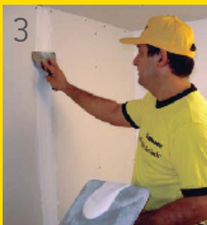
El revestimiento queda listo para la realización del tomado de juntas y el masillado de los tornillos.
