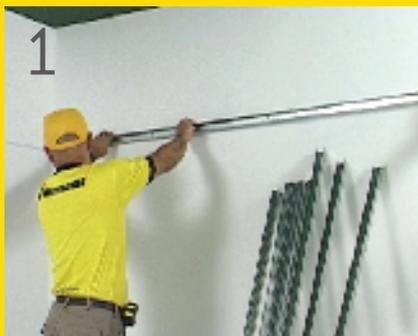
Una vez definida la altura del cielorraso, corte los perfiles, fije la primera solera sobre la pared del lado mayor del ambiente y repita esta operación en la pared enfrentada, cuidando mantener el mismo nivel. Para ello, utilice fijaciones tipo tarugo de nylon N°8 y el tornillo correspondiente, colocándolos cada 40cm.
