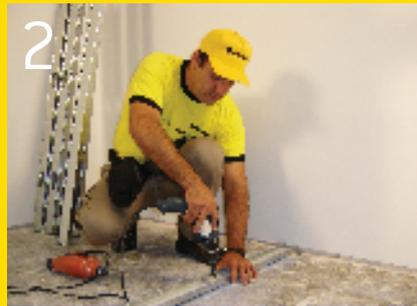
Fije una solera de 70mm al piso con tarugos de nylon N°8 y repita esta operación en el techo manteniendo la vertical con plomada o nivel laser.
