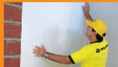
Pegue las placas a la pared o muro y aplómelas con cuidado con la ayuda de una regla de aluminio. Coloque sobre el piso dos trozos de placa 12,5mm para apoyar las placas Revoque Seco y evitar el ascenso de humedad por capilaridad.
