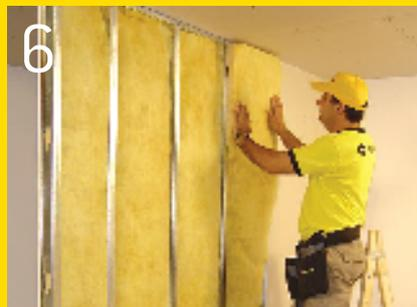
Para optimizar la aislación termoacústica, utilice material aislante, aplicándolo previamente al emplacado de cierre. Finalmente realice el tomado de juntas final.
