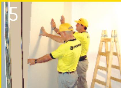
Luego colocar las placas fijándolas a los montantes, con tornillos T2 cada 30cm y a 15cm en los bordes que coincidan con los montantes. Las placas se colocan en vertical u horizontal, trabando las juntas. Deje una luz con el piso de 1,5cm.
