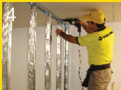
Ubique verticalmente los montantes, cada 40cm, dentro de las soleras inferior y superior, fijándolos a éstas con tornillos T1.
