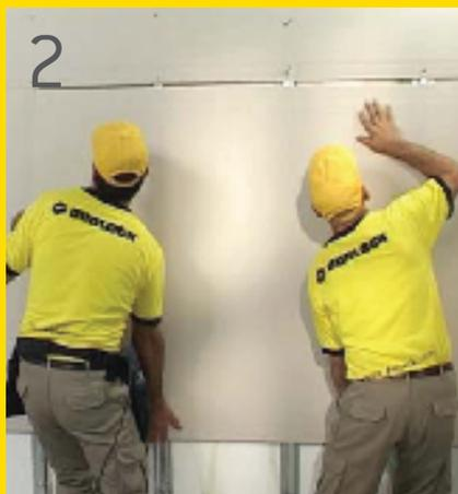
Una vez armada la estructura, usted podrá colocar las placas Durlock®. Para fijarlas a los perfiles omega utilice tornillos T2, colocándolos a 30cm y a 15cm en los bordes de placas (juntas) que coinciden con el perfil. Las placas se colocan en sentido vertical u horizontal, trabando las juntas. Recuerde dejar una separación entre la placa y el piso de 1,5cm utilizando como guía un trozo de placa que luego se retirará.
