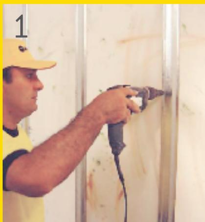
Primero, fijar, a la pared a revestir, perfiles omega de chapa galvanizada N° 24, sobre los que fijará las placas Durlock® de 12,5mm de espesor. Corte los perfiles omega de acuerdo a la altura de la pared a revestir y ubíquelos cada 40cm entre sí, fijando los perfiles metálicos con tarugos de nylon N° 8 y los tornillos correspondientes. Si la pared presenta deformaciones agregue un suplemento al perfil para mantener el plomo.
