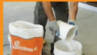
Prepare el adhesivo para fijar las placas. (Dosificación: 2 partes de polvo + 1 parte de agua)
