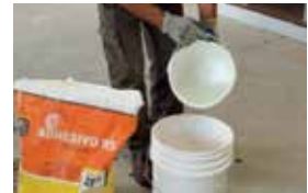
Dosificación del Adhesivo RS: 2 partes de polvo + 1 de agua.
