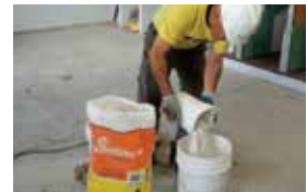
Dosificación del Adhesivo RS: 2 partes de polvo + 1 de agua.
